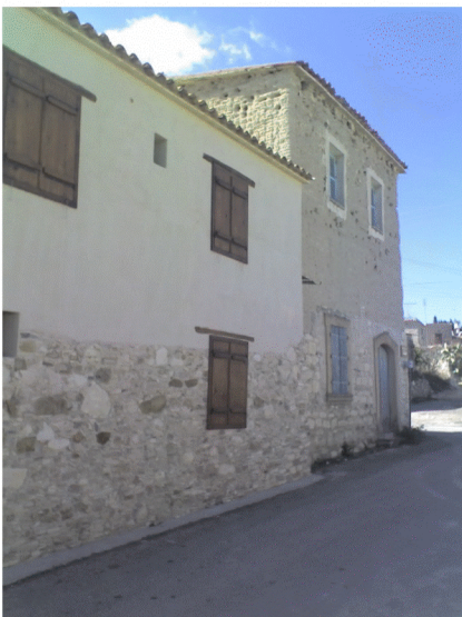
Επίχρισμα ασβέστη (εσωτερικά & εξωτερικά)
