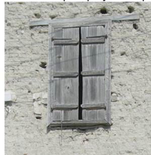
Κατασκευή θύρας & παραθύρων
