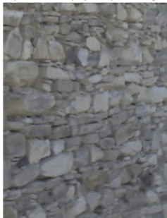
Ημικατεργασμένος ασβεστιτικός ψαμμίτης
