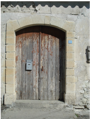
σανιδωτές πόρτες με τοξωτό υπέρθυρο από πελεκητή πέτρα
