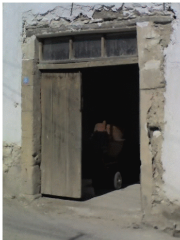
σανιδωτές πόρτες με ορθογώνιο υπέρθυρο (κατασκευασμένο από πελεκητή πέτρα) και φεγγίτη
