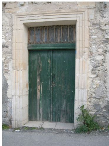
σανιδωτές πόρτες με ορθογώνιο υπέρθυρο (κατασκευασμένο από πελεκητή πέτρα) και φεγγίτη
