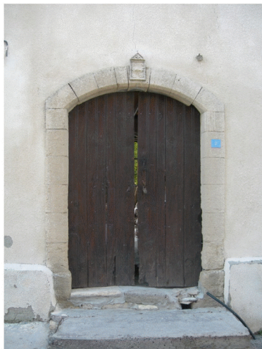
σανιδωτές πόρτες με τοξωτό υπέρθυρο από πελεκητή πέτρα
