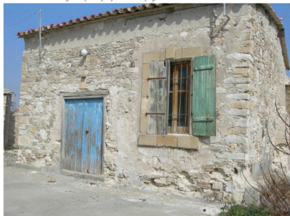
Ημικατεργασμένος ασβεστιτικός ψαμμίτης
