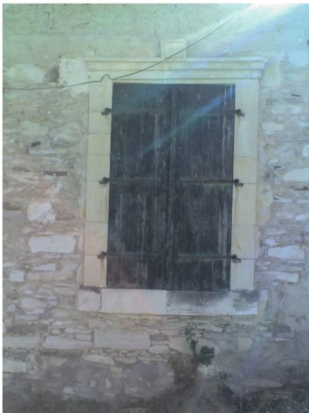
παράθυρα με πελεκητό πλαίσιο και σιδεριά
